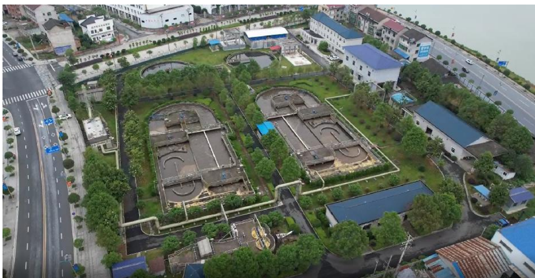
县城现状污水处理厂
